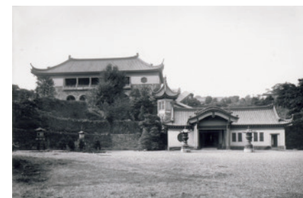
「大倉集古館外観」昭和2年(1927)
